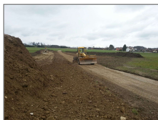
Mit Grader Planie erstellen
