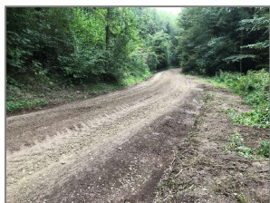
Abranden und bestehendes Kies aufziehen
